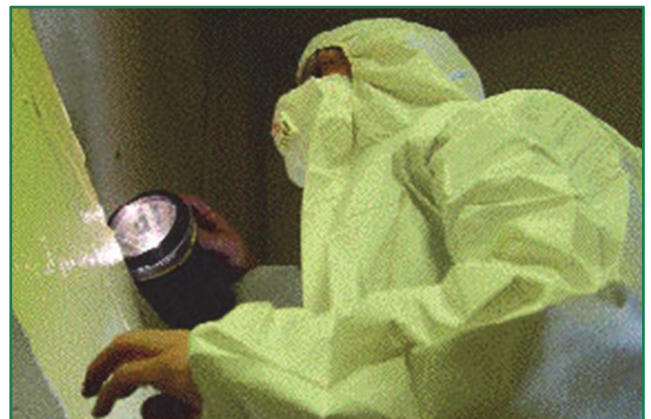
図 6.3 付着した細かい粉じんを懐中電灯で照らす
