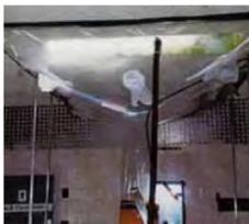
7.52 グローブバッグを用いるときも、通常は隔離空間を設ける必要がある。グローブバッグに漏れ又は不具合が生じた場合に他の人々への危険がほとんどないことが評価書に示されている場合のみ、隔離空間を設置せずにグローブバッグを用いることができる。例えば、現場が他の一般労働者から離れている事例（例：屋外配管のある化学工場において、予想される天候状態により隔離空間の構築及び維持が実行困難になり得る場合）がこれに該当する。ただし、比較的低濃度の繊維が使用中のグローブバッグから、特に小さな穴から漏れ出る可能性はなくなることを忘れてはならない。従って、作業区域はやはり隔離する必要がある。グローブバッグは、人がいる空間で隔離空間や負圧ユニット（NPU）などの追加的な予防策を取らずに用いてはならない。
