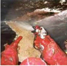
7.37 建築物が使用されておらず、解体予定の場合、隣接するエリアに比較的人が少ないことから、わずかではあるが作業が容易になる。建築物を密閉し（可能であれば細かく区切って）、現場の煙試験を行うことができる。これにより、ばく露及びアスベスト繊維の拡散を制御するのに十分な、管理下での湿潤除去技術を用いることが可能になる。制御が適正であることを確認するには、漏気サンプル採取を行う。
