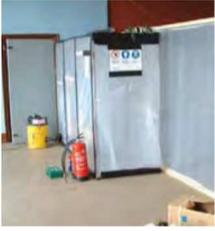
6.22 アスベスト廃棄物の撤去作業のためには別途隔離空間を設計し、組み立てなければならない。通過施設に類似するセキュリティルームの人の入退出口(エアロック)のシステム(廃棄物用セキュリティゾーン(バグロック)という)は、隔離空間内からのアスベスト廃棄物の撤去に利用できる。図 6.8 に廃棄物用セキュリティゾーン(バグロック)の構造を示す。作業員用セキュリティゾーン(エアロック)及び廃棄物用セキュリティゾーン(バグロック)を別々に組み立てられない場合は、混成での設置を行う。衛生ユニットが隔離空間に直結しているか、あるいは 3 ステージの作業員用セキュリティゾーン(エアロック)(すなわち通過)が含まれているかによって混成システムの設計は変わる。図 6.9 及び 6.10 に、さまざまな選択肢を示す。アスベスト用廃棄袋の清掃、ラベリング、移動の手段と手順は、図 6.8 及びコラム 7.6 に示す。
