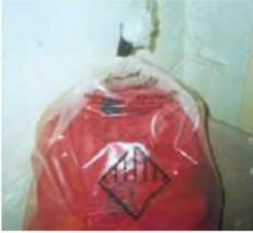
7.92 ほとんどの場合、認可された除去作業で出るアスベスト廃棄物は CDG 要件の免除規定に該当しない。従って UN 認定梱包材を使用して廃棄物を二重に袋詰めし、密閉コンテナ、貨物用コンテナ又は施錠された車両に搭載する必要がある。標準的な作業方法は赤い内袋と透明な外袋を使用することである。赤い袋にアスベスト警告表示を行う。袋には過剰に廃棄物を入れたり、素材を突き破るような尖ったものを入れたりしてはならない。認定梱包材は最大で 2 トンまでの容量のものがある。
