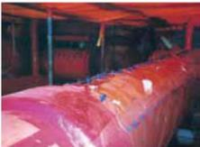
図 7.9 グッドプラクティス：配管への湿潤剤の注入
