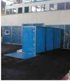
6.1 隔離空間は、除去作業時にアスベスト含有材を管理するための基本的な措置である。本章では、隔離空間の機能と目的について説明し、アスベストを取り扱う際の隔離空間の設計及び設置、使用法に関する実践的な助言を提供する。通常、隔離空間は以下の機能が求められる。
