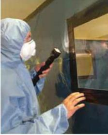
6.55 覗き用パネルは頻繁にチェックし、隔離空間内部の鮮明な視界をできる限り確保するために清掃する必要がある。パネルは必要に応じてきれいに拭くことができる。空中に浮遊する粉じんは、アクリルガラスの表面に容易に付着するので、隔離空間内で発生した粉じんの量の指針となる。粉じんを定期的に清掃しなければならないということは、制御下の除去技術の有効性が限定的であることを示している。
