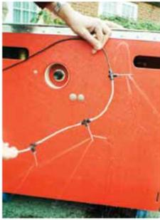
7.23 注入による湿潤化の技術は、管理下で均一に ACM を湿潤化するよう、低圧で運用しなければならない。湿潤化は毛細管現象によって起こるが、下方向への浸透は重力に助けられる。湿潤剤は、3.4 バール (50psi) 未満の圧力で供給しなければならない (流量値を個別に設定できる針の場合、より適切な流量制御が可能)。これ以上の圧力を用いると、湿潤剤は必然的に最も抵抗が少ない通り道 (例：ひび、割れ目) に沿っていき、不完全な湿潤につながる。
