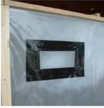
6.50 隔離空間では、集じん・排気装置のスイッチを切り、隔離空間内に煙発生器で煙を発生させて検査を行うものとする（第 6.17 項参照）。煙が逃げているということは、可能な限り対処しなければならない漏洩があることを示している。
