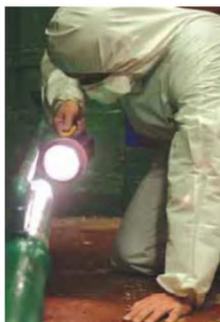
7.115 この段階では、隔離空間又は作業区域の徹底的な目視検査を行う。検査手順の最も重要な部分である。アナリストは以下の点についてチェックしなければならない。
