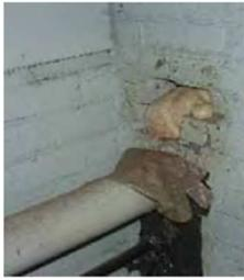
注：極めて狭い空間で特定の発泡剤及び接着剤を高温の配管に使用したり、換気ゾーンの近くで使用すると、高濃度の有害ガスが発生する恐れがあるため、こうした使用は避けなければならない。健康へのリスクを特定し、適切な管理と保護具を明確にするために、あらゆるシーリング剤又は接着剤の使用についてはリスク評価（RA）で検証する必要がある。さらに、作業完了後に発泡剤が残存する場合には、防火規制に影響を及ぼす恐れがある。
