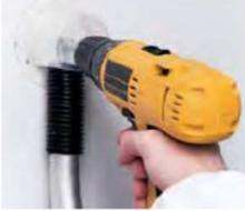
図 7.7 凹凸のある塗材にペーストを介してドリルで穴を開ける
