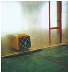
6.18 隔離空間内の空気の除じん率のみならず、構造物の物理的な大きさや形状、漏出の規模（すなわち、密封の有効性）、外部の気象状態によって圧力差は決まる。つまり、風向きの変化に応じて隔離空間内が加圧される可能性がある。大規模で広範な設備又は長く続く配管のアスベストを除去する場合には、1つのユニットとして作業を進めるより空間をいくつかに区分して、小さい隔離空間を設置する方が適切であろう。発電所のように極めて大きな隔離空間では十分な負圧に達することは難しいかもしれないが、十分な負圧がない状態で作業区域近辺に空気の流れを発生させるために負圧ユニット（NPU）（図 6.5 参照）が有効であろう。
